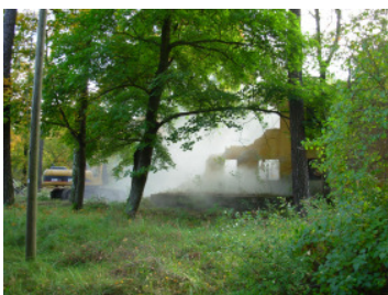
Foto 2: Rückbau ehemalige milit. Liegenschaft
