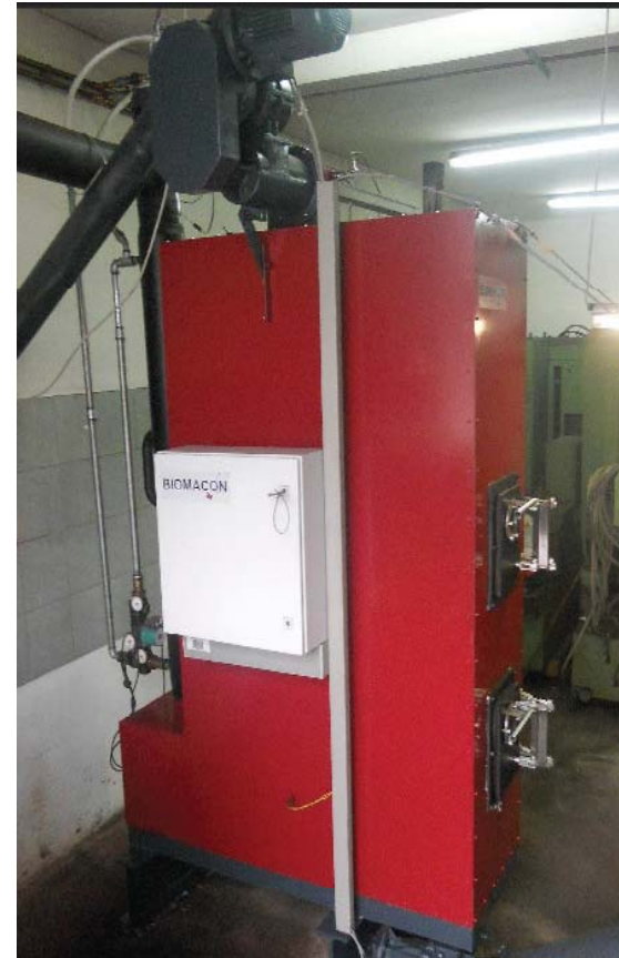
TerraBoga: Klein-Holzvergaser im Bau (ca. 60 t/a Restholz; ca. 60 kW Heizleistung)
