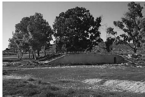
Abb. 12 Balsa de San Ricardo am südlichen Ende des Qanat-Systems von Torralba. Das innere Becken ist heute gemauert und verputzt und geht auf den Anfang des 20. Jahrhunderts zurück; die wallartige Umfassung des Beckens deutet jedoch auf eine wahrscheinlich mittelalterliche Anlage hin.
