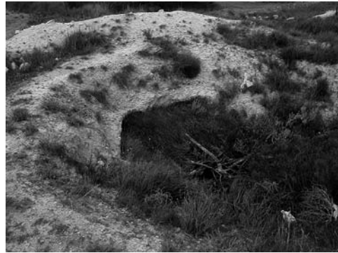
Abb. 16 Geschleifter Schacht und Aushub des Qanat-Systems an der Ölmühle La Almazara in der Vega von Velez Blanco.
