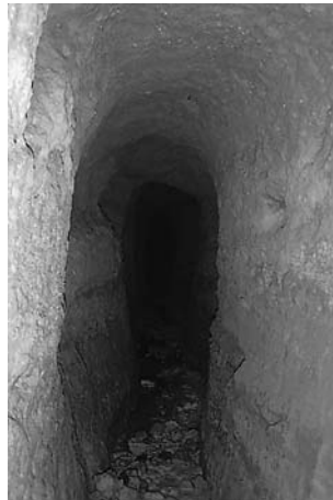
Abb. 8 Nach Süden streichendes Stollensystem des Schachtes in Fig. 7. Deutlich sind die Bearbeitungsspuren an den Wänden und unten der gepflasterte Boden erkennbar.
