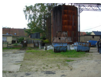
Foto 3: Hochbehälter innerstädtische Industriebrache
